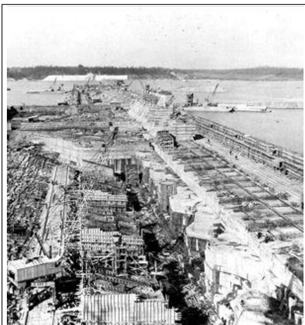
Construction du barrage Wheeler sur le fleuve Tennessee. © Albert Harlingue / Roger-Viollet
