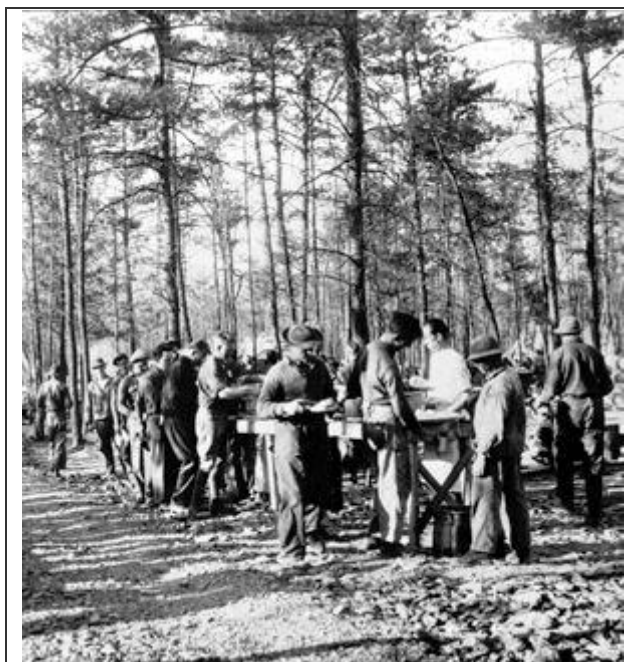
Grands travaux pour occuper les chômeurs, cantine sur un chantier. © Roger Viollet
